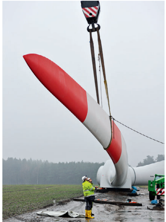
Rotor-Installation im Windpark Ketzin.
