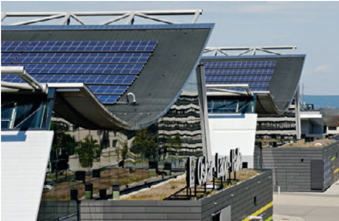
Fotovoltaik auf den Dächern der Neuen Messe Stuttgart.
