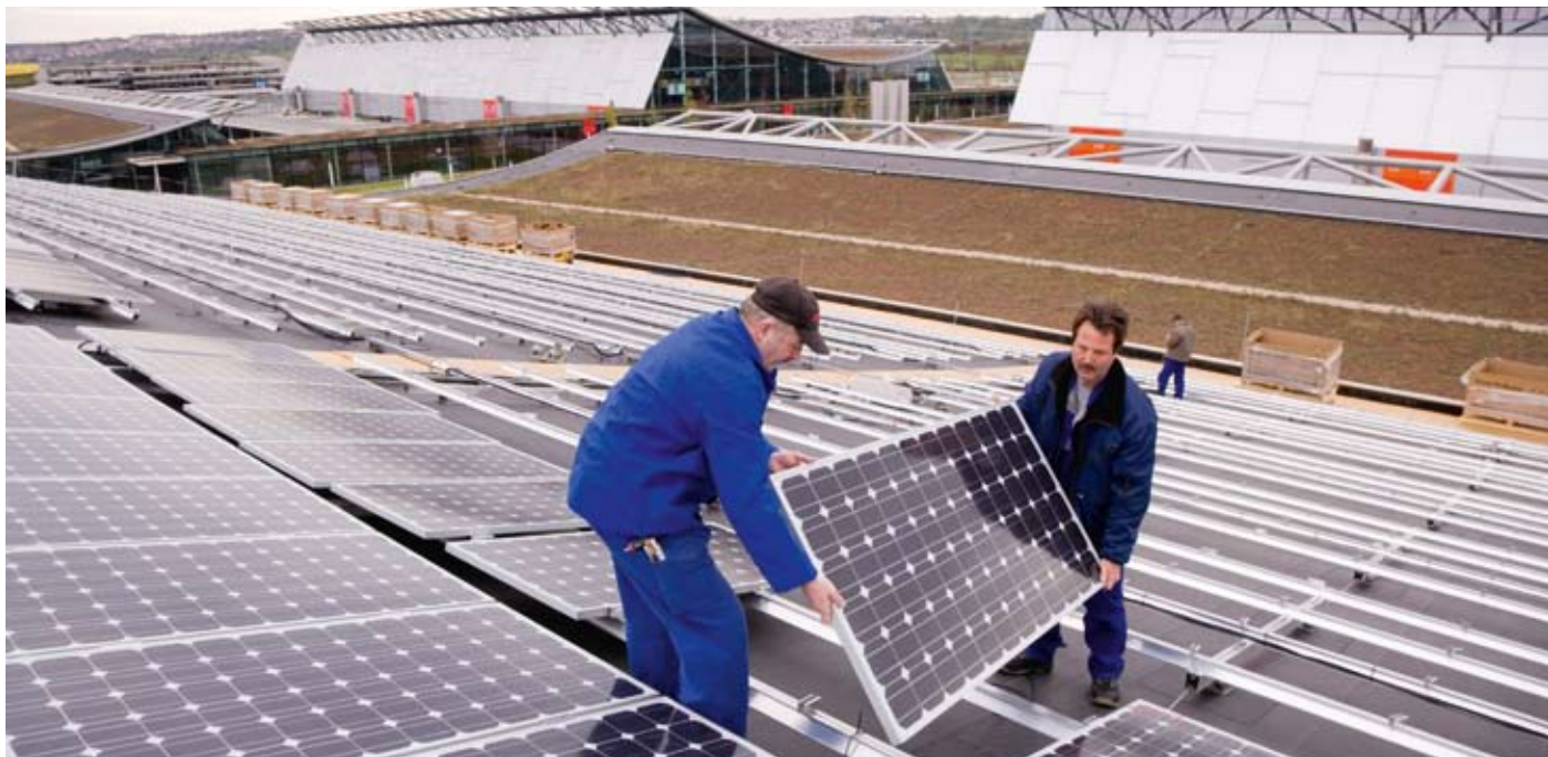
Fast 22.000 Solarmodule werden auf den Dächern der Neuen Messe Stuttgart montiert.
